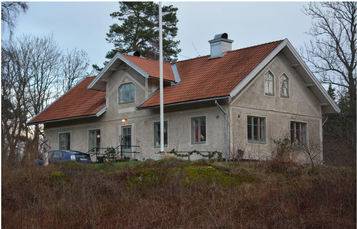
Tegelhagens gård, fd arrendatorsbostaden
